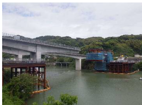
写真-1 施工箇所全景
