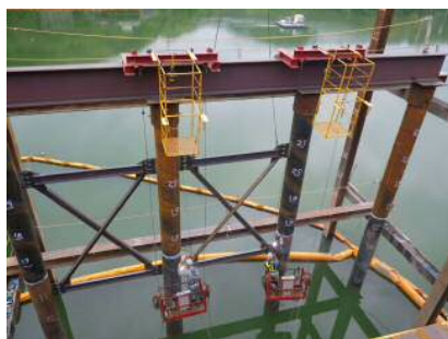
写真-4 ブレス取付け状況
