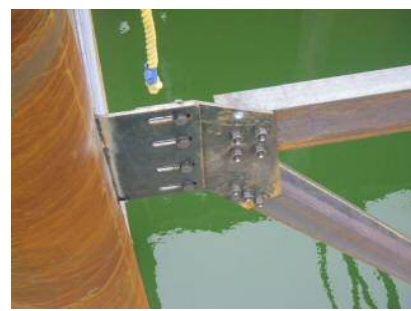
写真-5 ブレス接合部
