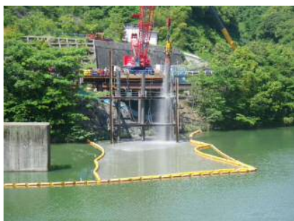
写真-3 杭打ち状況
