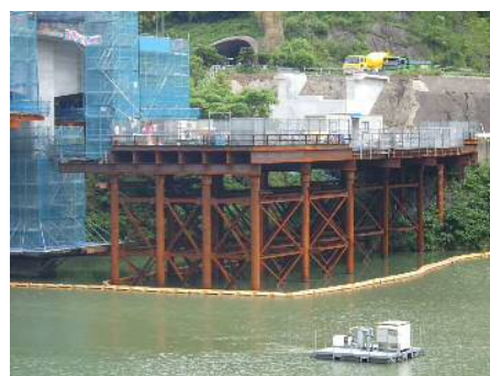
写真-6 施工完了
