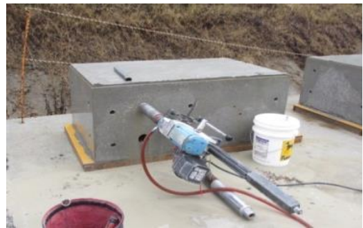
写真-2 コンクリートコア採取状況
