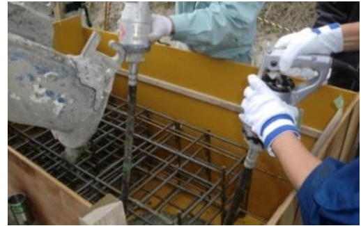
写真-1 コンクリートの打設状況
