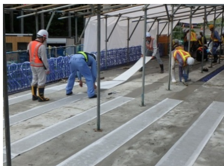
写真-4 保水養生シート施工状況
