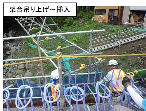
写真-3 エポキシ樹脂被覆PC鋼材の挿入状況
