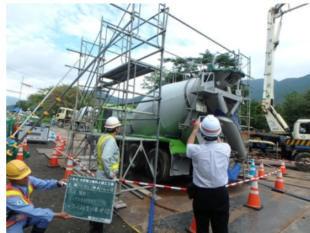
写真－7 待機場所での散水装置使用状況
