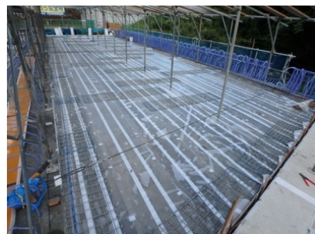
写真-5 液体搬送型養生テープ施工状況
