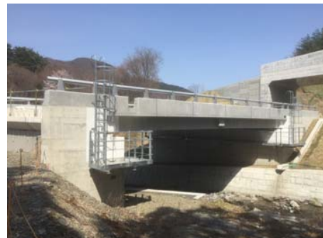
写真－10 不動沢橋完成状況
