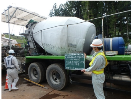
写真－6 ドラムカバー装着状況
