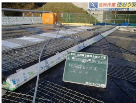
写真－8 中央分離帯養生状況
