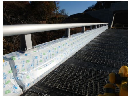
写真－9 地覆・壁高欄養生状況
