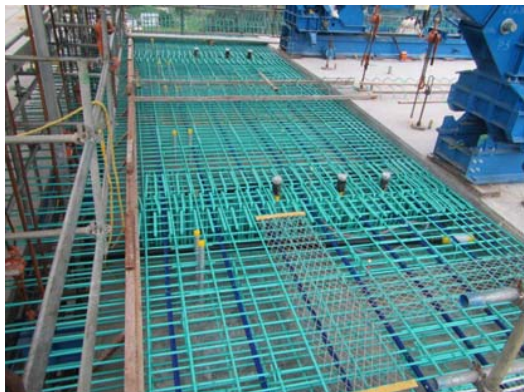
写真-1 上床版鉄筋組立完了 (エポキシ樹脂塗装鉄筋)
