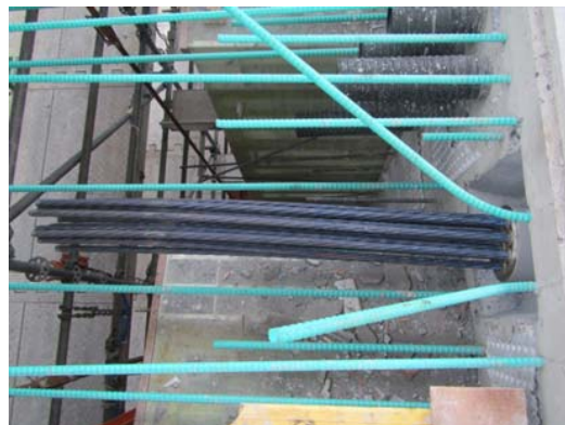
写真-2 内ケーブル (エポキシ樹脂被覆ケーブル)
