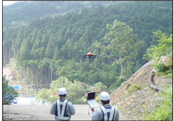
写真-3 ドローン打上げ状況
