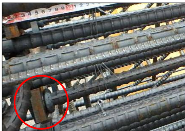
写真-1 プレート定着型せん断補強筋「Head-bar」
