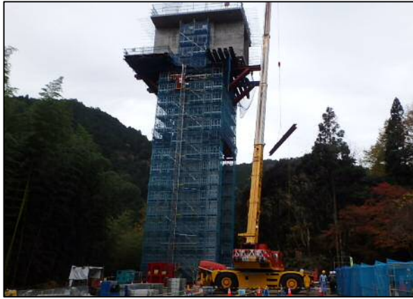
実橋での架設状況
