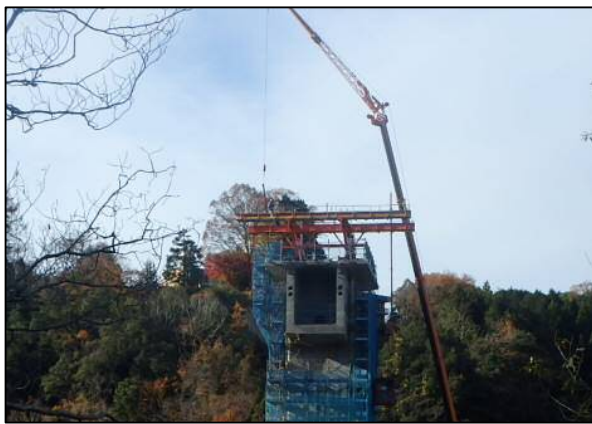
実橋での架設状況
