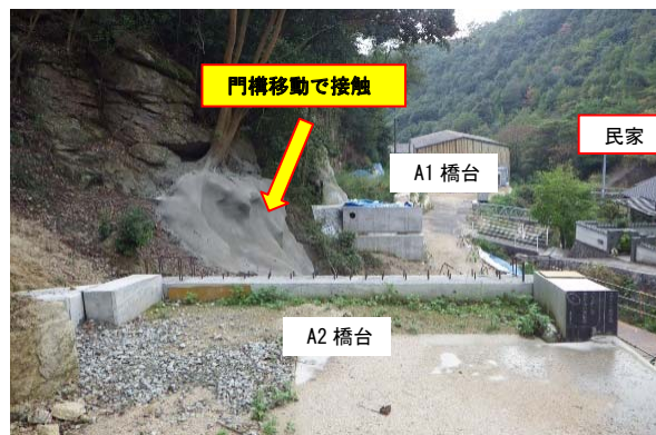
写真-2 架設地点状況
