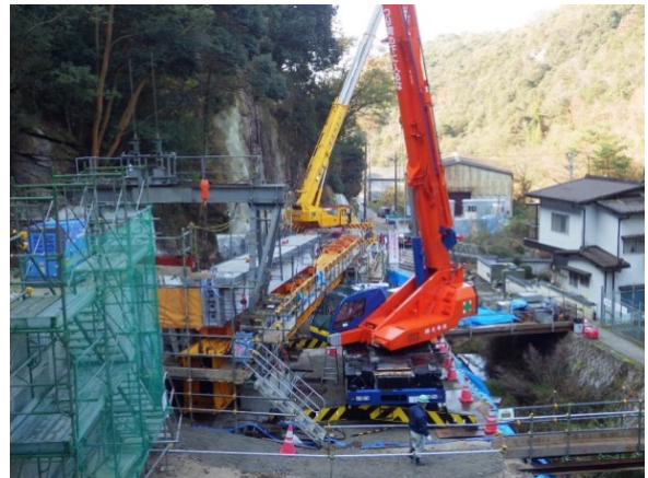
写真-3 架設状況
