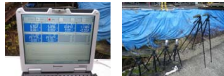
【モニタリング画面】 【距離計設置状況】
