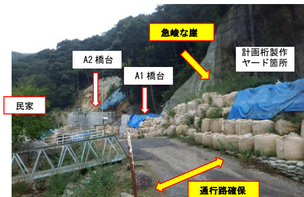
写真-1 製作ヤード地点状況
