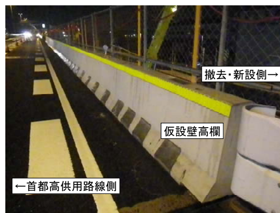
写真-5 仮設壁高欄配置
