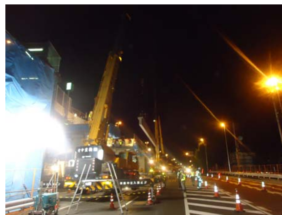
写真-6 桁架設状況
