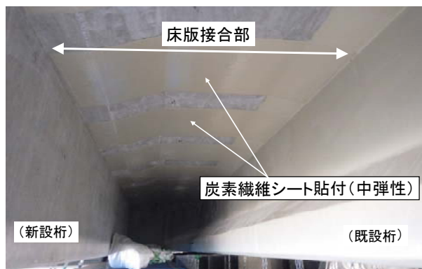
写真-3 床版接合部炭素繊維シート補強
