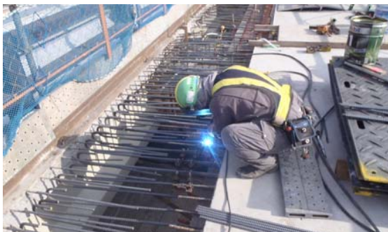
写真-2 エンクローズ溶接状況
