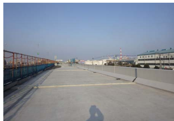
写真-7 拡幅部完成写真(橋面上)
