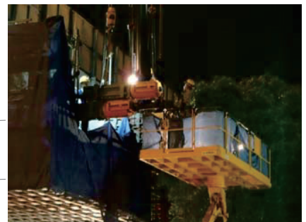
写真-5 外ケーブル緊張状況
