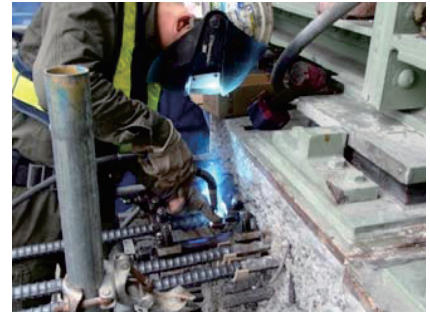
写真-3 突き合せ溶接継手
