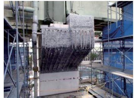
写真-2 既設梁はつきり状況
