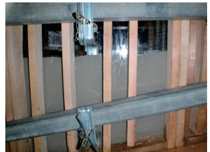
写真-4 透明型枠の設置
