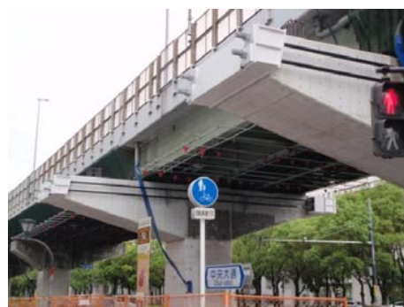
写真-6 現況 (下部工完成)
