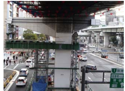
写真-1 張出し支保工
