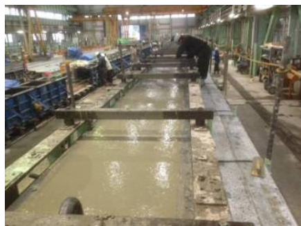
写真-1 コンクリート打設状況
