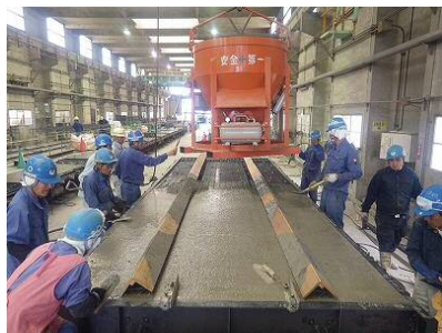
写真-4.1 コンクリート打設状況
