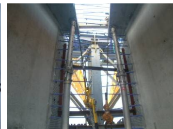
写真-8 主桁の固定
