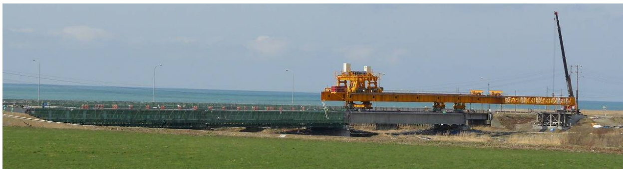
写真-9 本橋の全景 (平成28年4月末現在)
