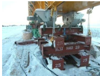
写真-3 電動送りローラー
