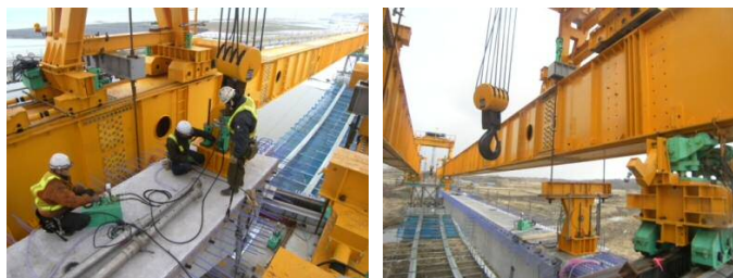
写真-5 桁吊金具取付け 写真-6 主桁吊替え
