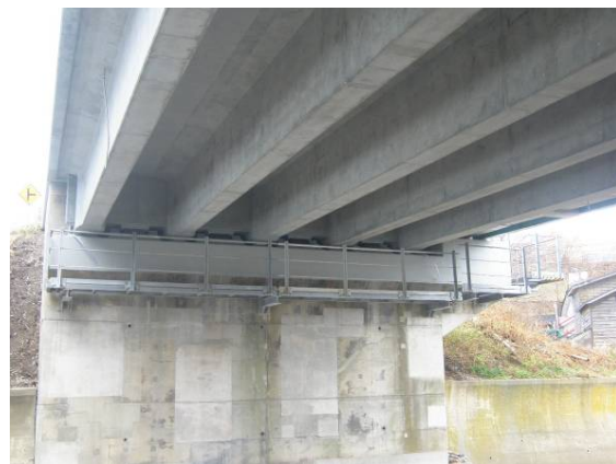
写真-12 完成（その2）
