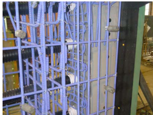
写真-10 主桁定着部
