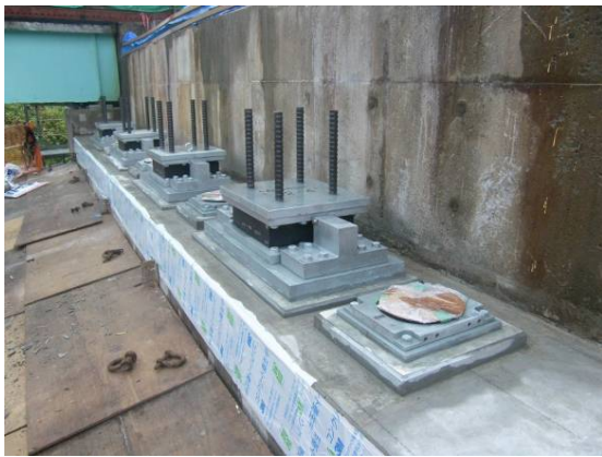
写真-5 支承設置状況
