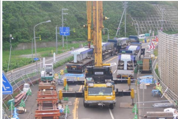
写真-2 セグメント搬入状況
