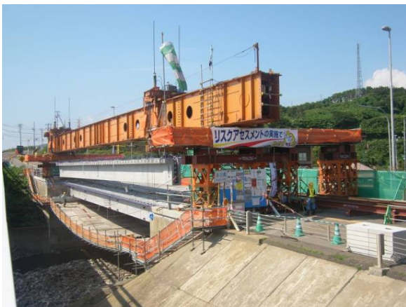
写真-7 主桁横移動状況
