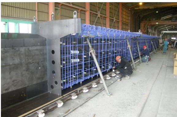
写真-3 セグメント製作状況
