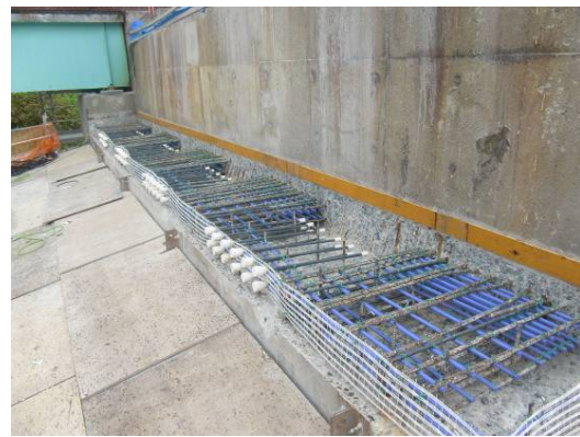
写真-6 橋座補強状況
