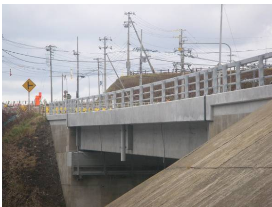
写真-11 完成（その1）
