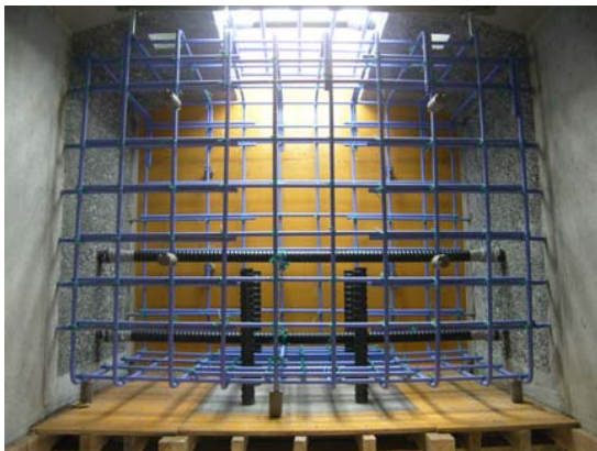
写真-9 横桁配筋状況
