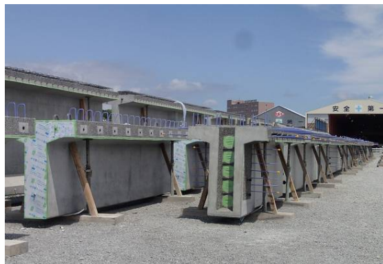
写真-4 セグメント仮置き状況
