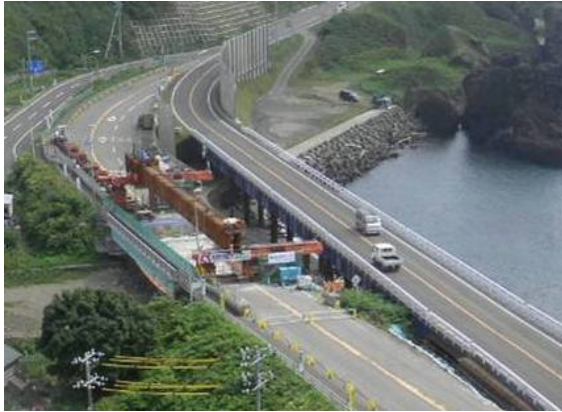
写真-1 施工箇所全景
