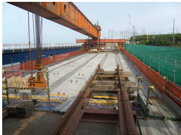
写真-8 主桁据付状況
