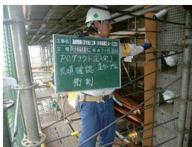
写真-1 樹脂製グラウトキャップの使用
