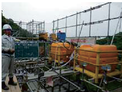
写真-3 パイプクーリング
