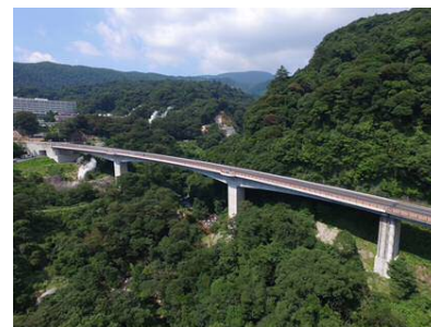
写真-9 完成した丸尾滝橋
