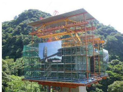
写真-6 P1設置大型移動作業車
