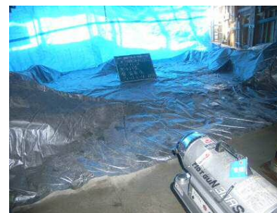
写真-5 保温養生
