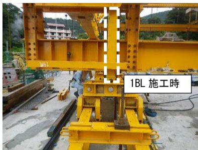
写真-7 支点スライド前
