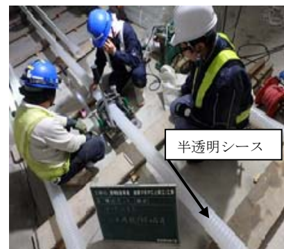
写真-4 シース接続状況
