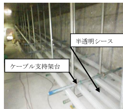
写真-5 ケーブル架台設置状況
