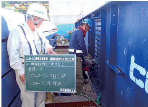
写真-3 シャイレンチ使用状況
