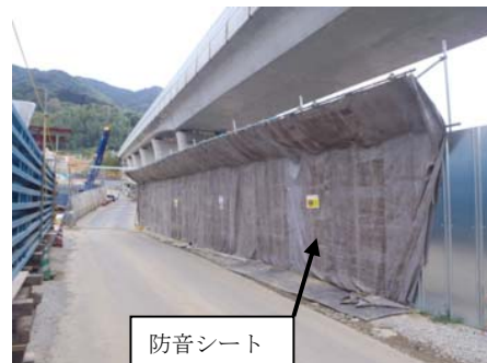
写真-2 防音シート設置状況
