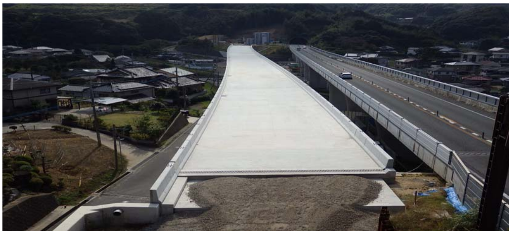
写真-6 完成写真
