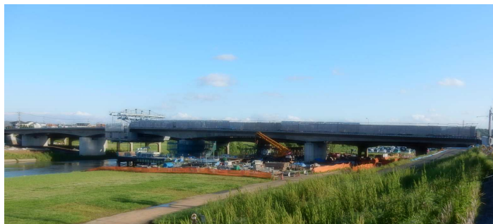
写真-2 施工状況
