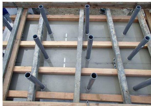
写真-3 充填完了後天端状況
