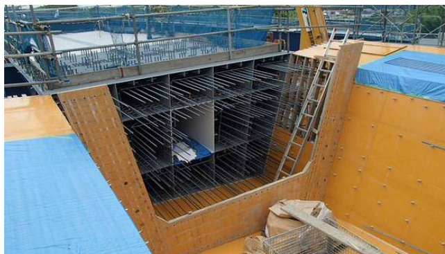
写真-4 鋼殻セルおよび接合部の型枠組立状況
