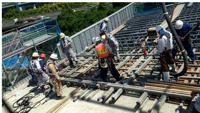
写真-5 接合部のコンクリート打設状況
