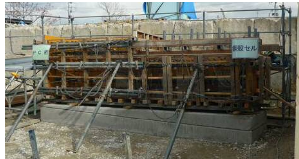
写真-1 打設実験用型枠
