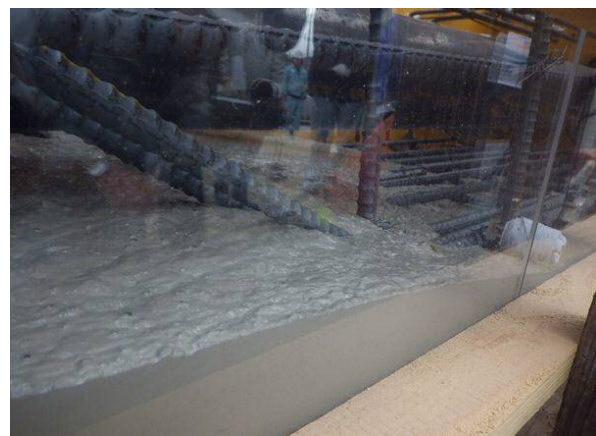
写真-2 型枠側面充填状況
