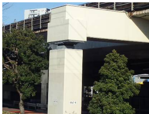
写真-4 支承取替後
