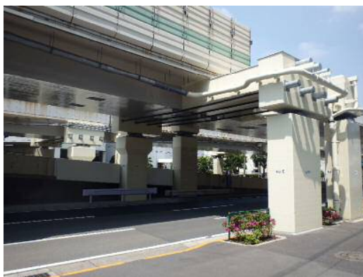
写真-3 新設下部工・横梁完成状況
