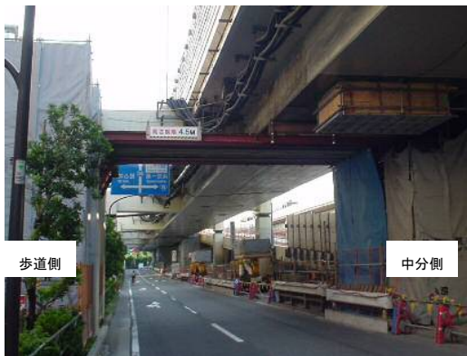
写真-2 新設横梁支保工設置状況
