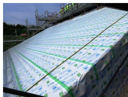
写真-1 構造物の養生状況
