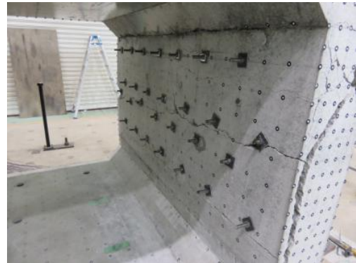
写真-3 復旧対策完了後(南側壁 内空側)
