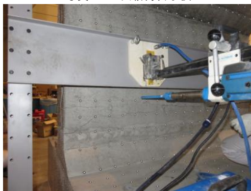
写真-2 削孔の様子
