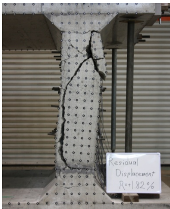
写真-4 復旧対策完了後(南側壁 西面)
