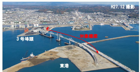
写真-1 臨港道路全景
