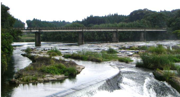
写真-1 撤去前の曾木大橋
