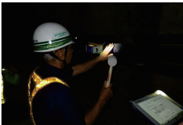
写真-2 衝撃振動試状況
