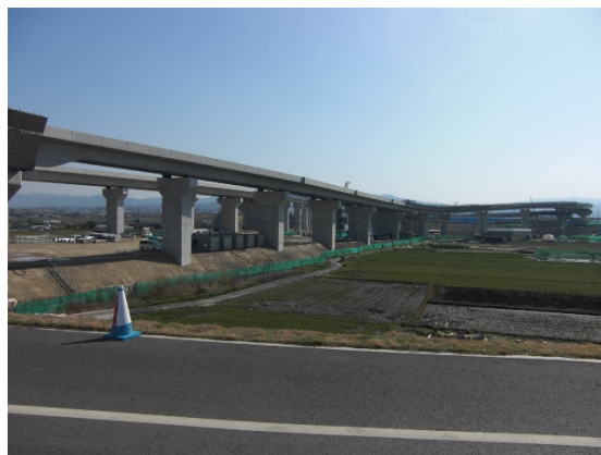
写真-1 C・Gランプ橋全景
