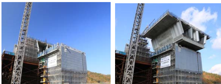
写真-1 施工状況（左：押し出し前，右：完了後）
