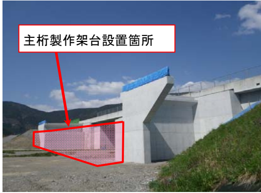
写真-2 橋台側面の主桁製作箇所
