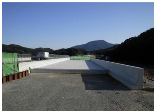
写真-8 完成写真(橋台背面より)
