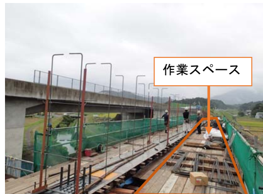
写真-4 資材仮置場(鉄筋組立時)
