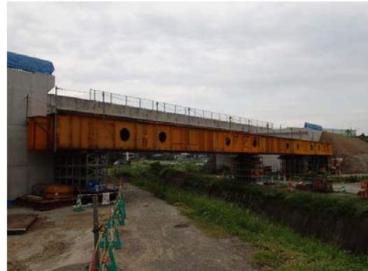
写真-3 主桁製作架台設置(側面)
