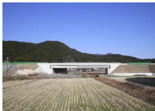
写真-9 完成写真(側面より)
