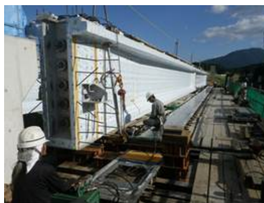
写真-7 主桁横取り架設状況
