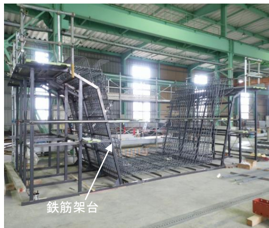
写真-1 鉄筋組立てプレファブ化
