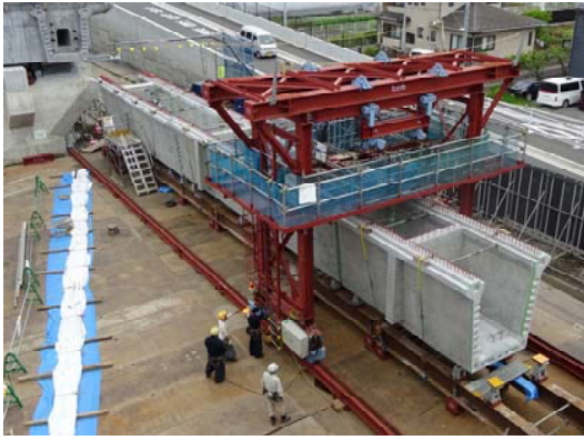
写真-2 セグメント引寄せ状況
