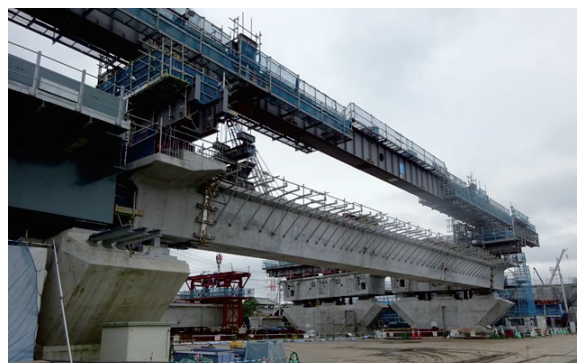
写真-3 U桁架設状況
