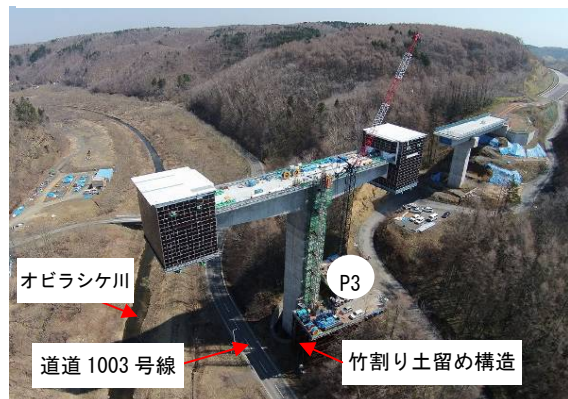
写真-3 道道上の施工状況
