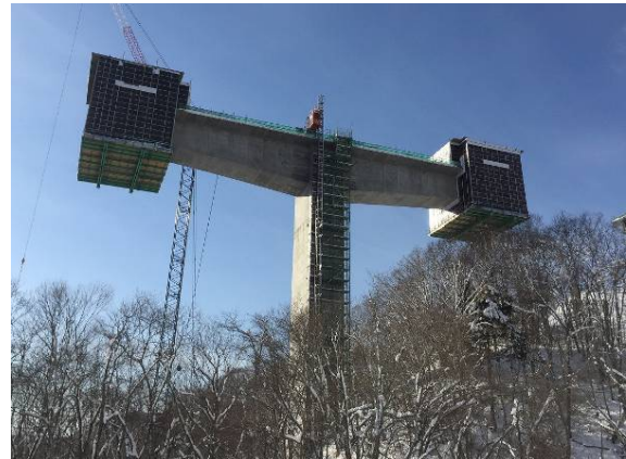
写真-1 防寒養生状況
