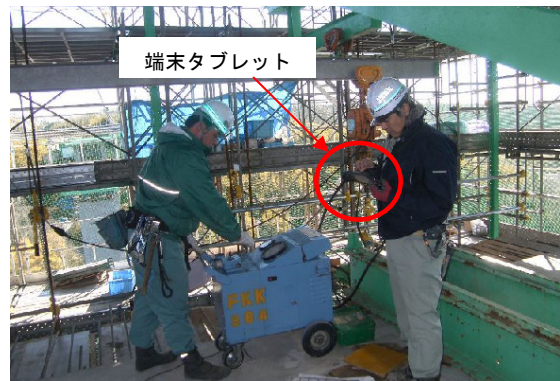
写真-2 IT端末を用いた緊張管理状況
