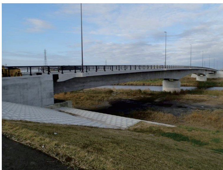
写真-4 完成写真
