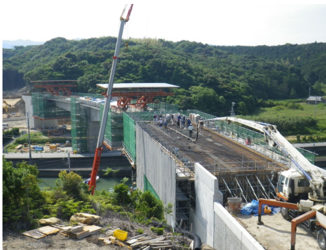
写真-1 全体施工状況
