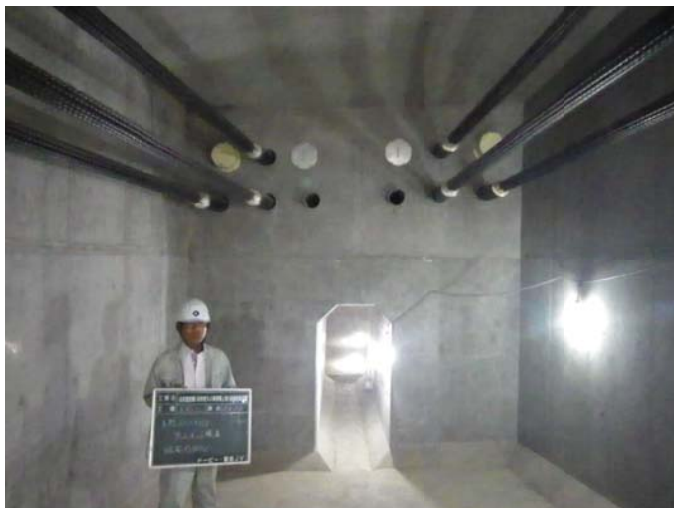
写真-2 外ケーブルの配置状況
