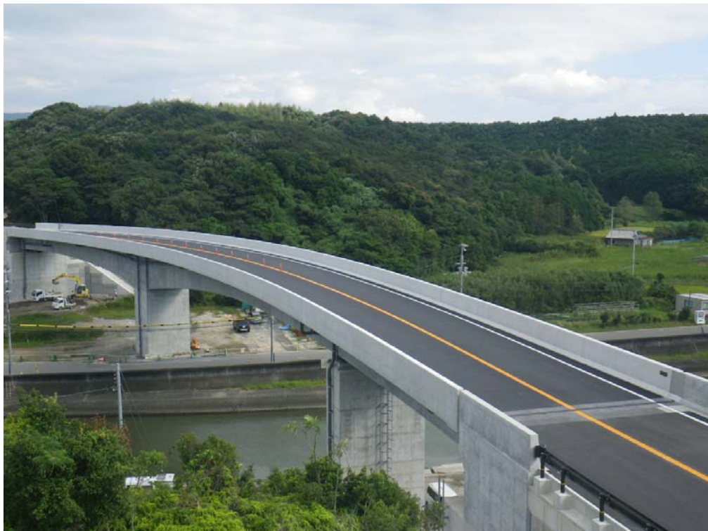
写真－5 橋梁完成
