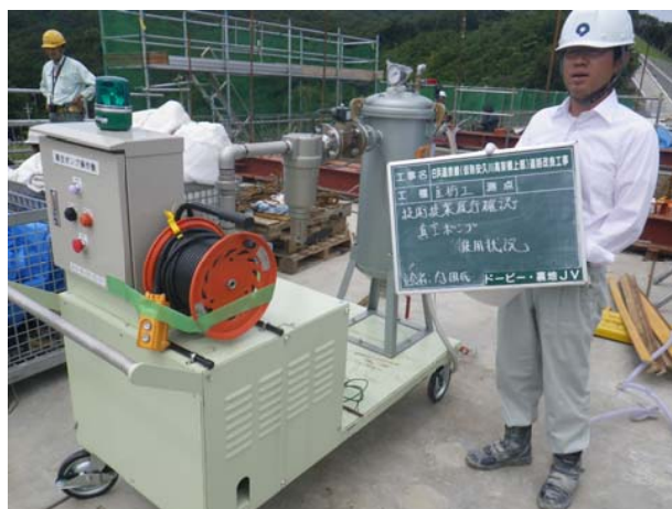
写真-4 真空グラウト工法 (真空ポンプ)
