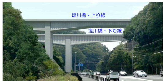
図-2 完成図(上:南より, 下:北より)
