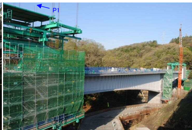
写真-4 橋体施工状況
