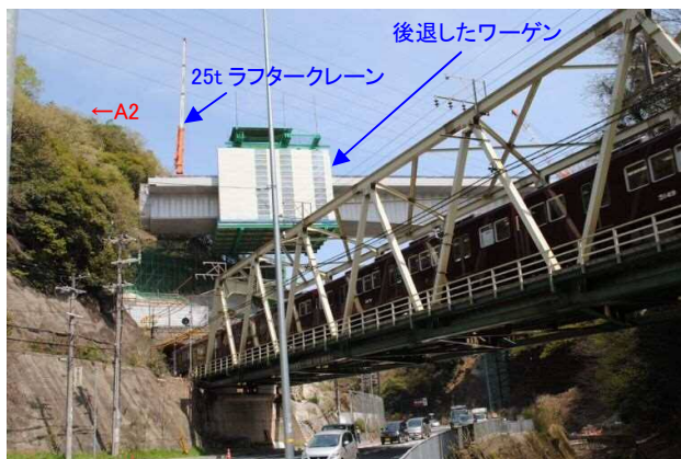
写真-3 クレーンとワーゲンの置換状況
