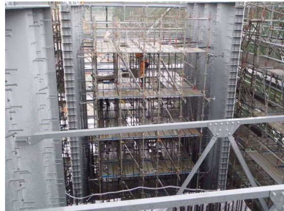
写真-1 柱頭部施工状況
