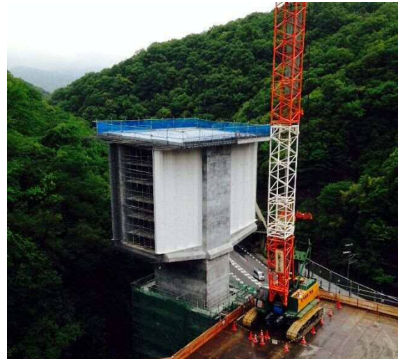
写真-2 柱頭部施工完了
