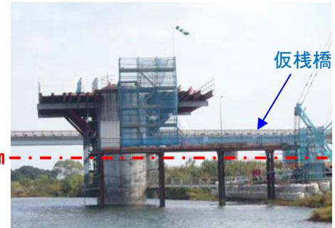
写真-1 柱頭部支保工
