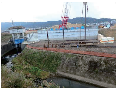
写真-3 H鋼杭施工
