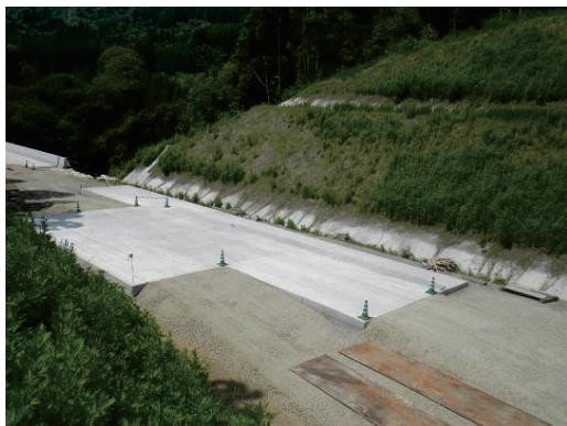
写真-1 調整コンクリート設置
