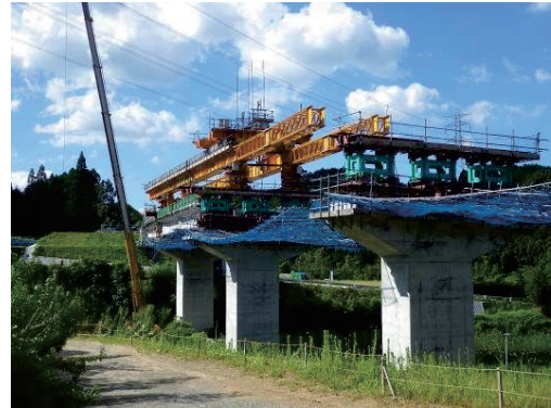
写真-3 二組架設桁による架設状況
