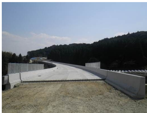
写真-5 完成写真
