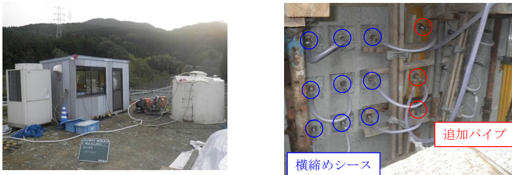
写真-4 パイプクーリング実施状況
