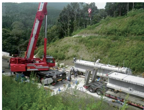
写真-2 桁取卸し・組立状況
