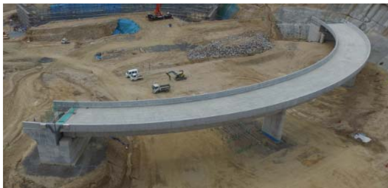
写真-2 橋体工完了後全景
