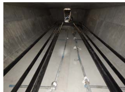
写真-3 緊張後桁内部
