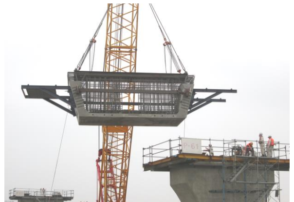
写真-4 海上部の中間支点セグメント架設
