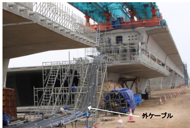
写真-7 PE被覆エポキシ外ケーブル(19S15.2)挿入状況
