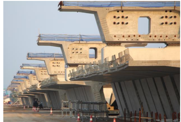
写真-3 先行して構築する支点セグメント
