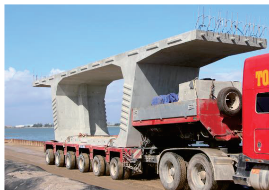
写真-2 多軸トレーラによるセグメント運搬
