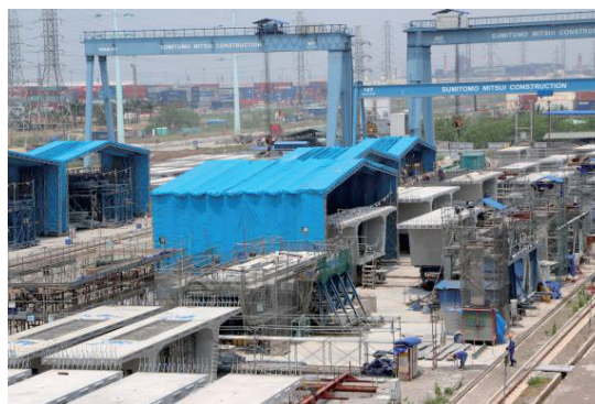
写真-1 製作ヤード全景
