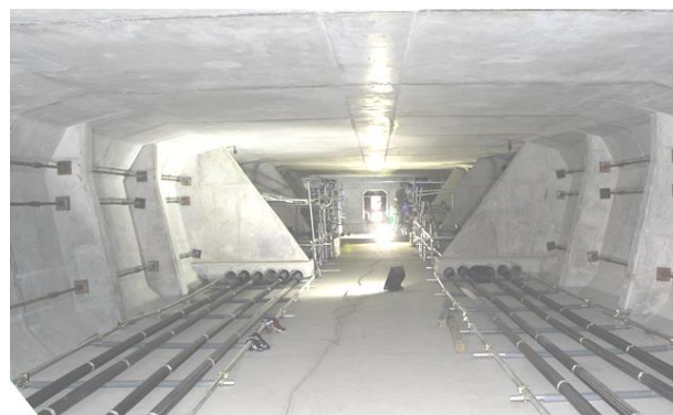
写真-8 桁内外ケーブル配置
