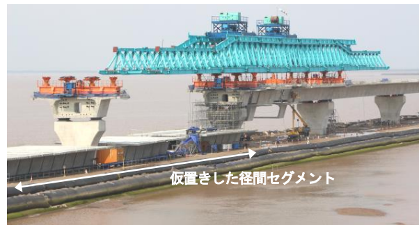
写真-6 先行して仮置きした径間セグメント
