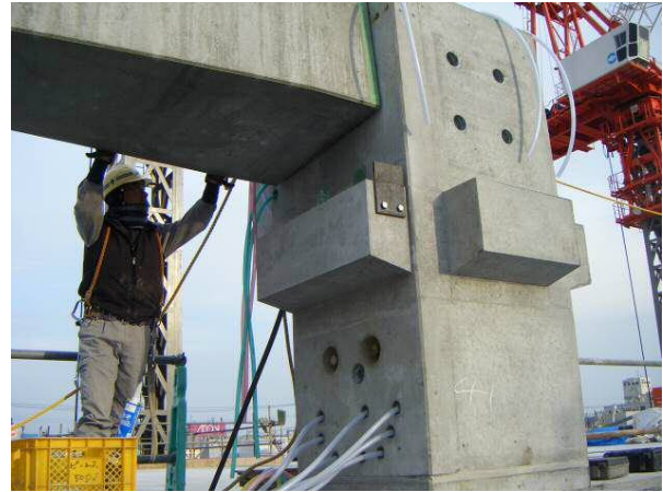
写真-4 大梁架設 (2)
