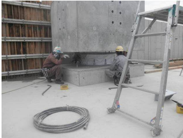
写真-1 免震ブロック架設
