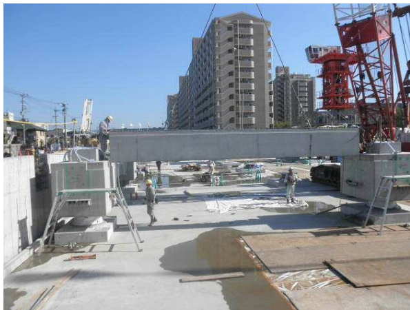
写真-3 大梁架設 (1)
