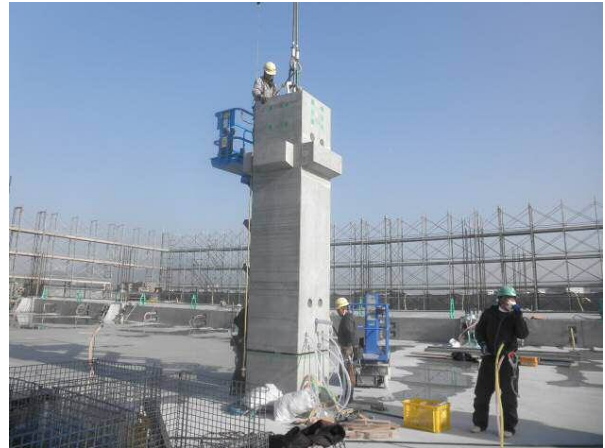
写真-2 柱架設
