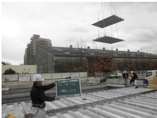
写真-5 PC合成床板架設
