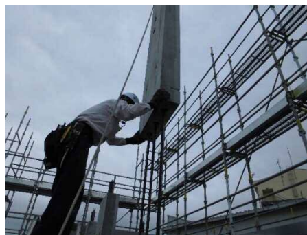
写真-5 壁版架設状況
