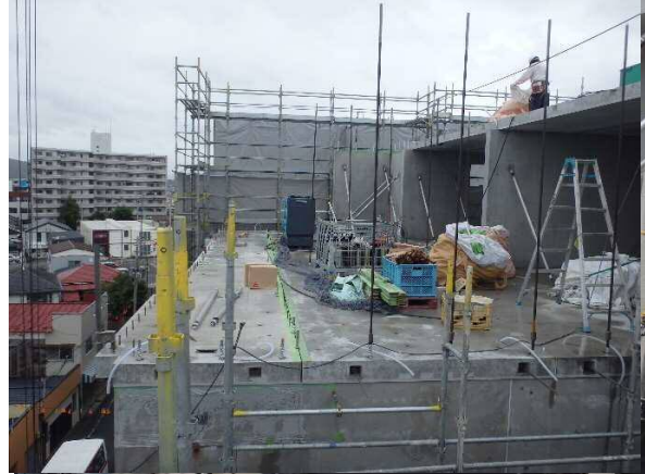
写真-2 ひな壇架設状況
