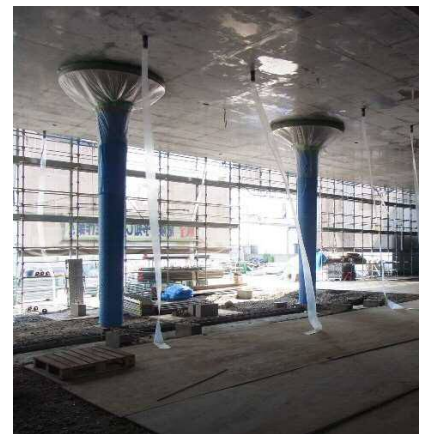
写真-1 丸柱(ピロティ)
