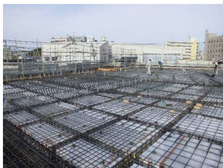
写真-4 人工地盤 打設前状況
