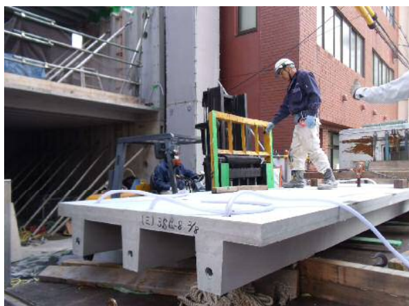
写真-3 フォークリフト部材荷卸し
