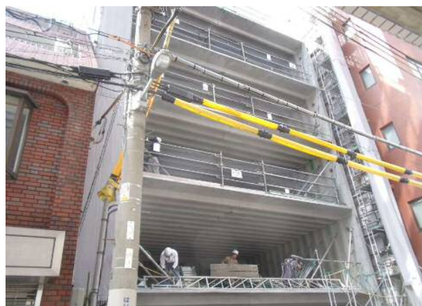
写真-4 PCaPC部材架設完了写真（北側）
