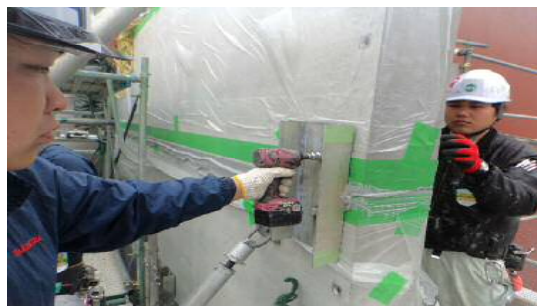
写真-2 C型チャンネル取付
