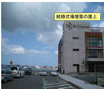
写真-1 増築前の建物外観
