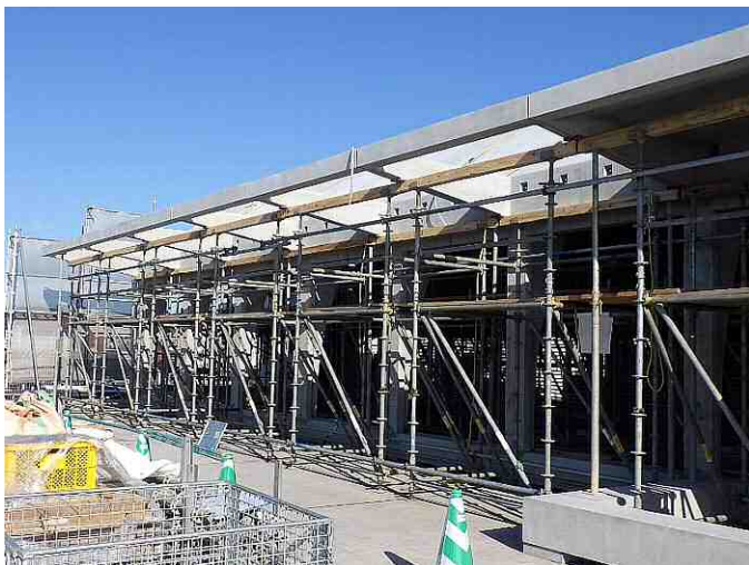
写真-8 底版架設
