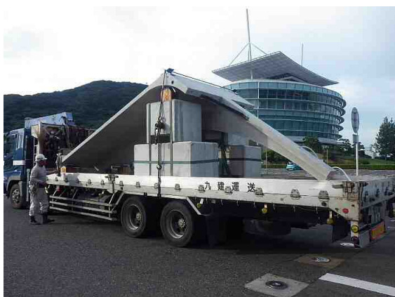
写真-4 屋根版搬入状況
