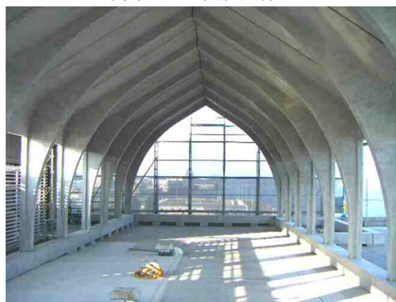
写真-7 屋根版架設後の内観
