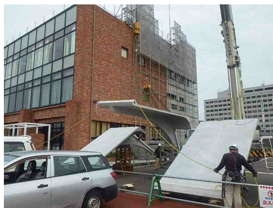
写真-5 屋根版架設
