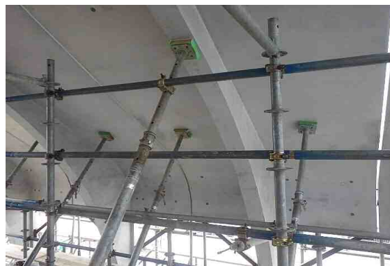
写真-6 屋根版支保工
