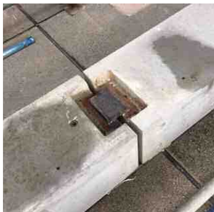
写真-2 土台接合状況
