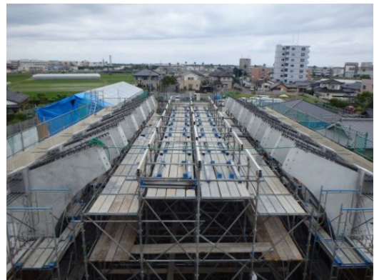
写真-7 V梁の施工完了
