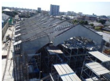
写真-9 X梁の施工完了
