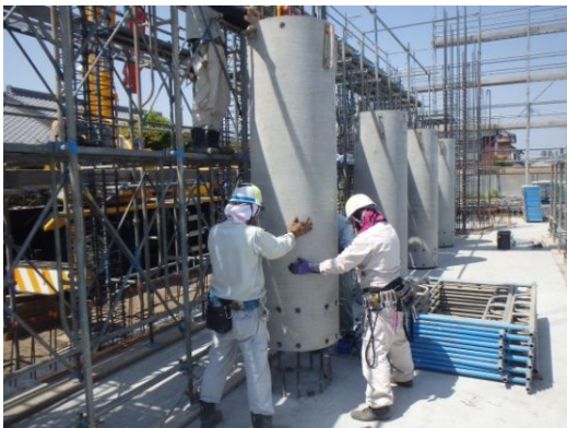
写真-6 1段目丸柱の施工状況
