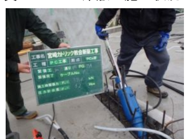
写真-13 プレストレス導入(外端梁)
