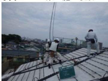
写真-11 PC鋼材の挿入状況
