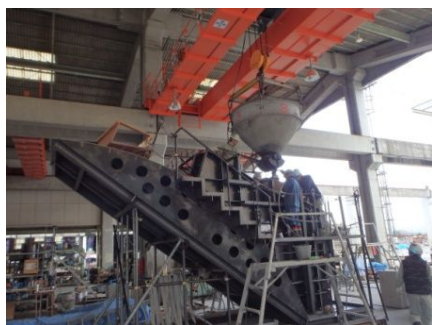
写真-2 V梁の製作状況
