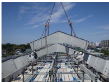
写真-8 X梁の施工状況
