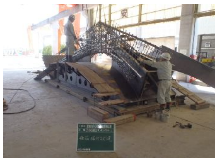
写真-3 X梁の製作状況
