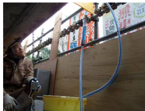
写真-4 水溶液注入状況(自然流下)
