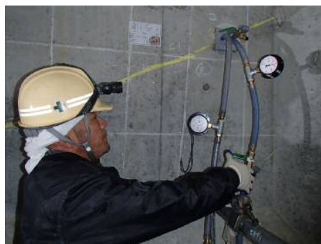
写真-3 水溶液注入状況(削孔箇所)
