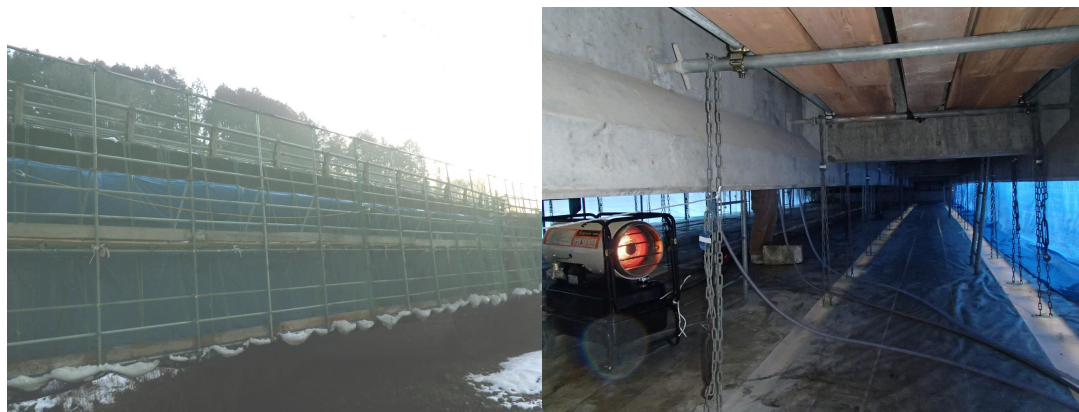
写真-2 寒中条件下での加温養生の一例
