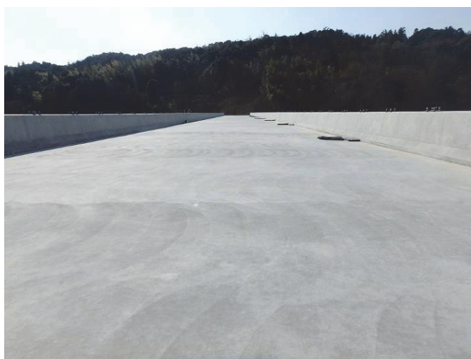
写真-2 下坂本高架橋完成写真
