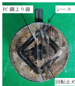
写真-4 特殊接続装置のグラウト状況
