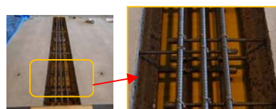
写真-1 接合部鉄筋組立状況
