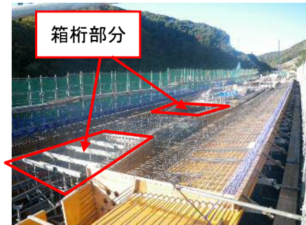
写真-2 主桁型枠鉄筋組立状況
