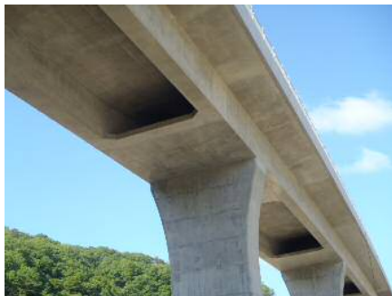
写真-5 柱頭部付近箱桁断面
