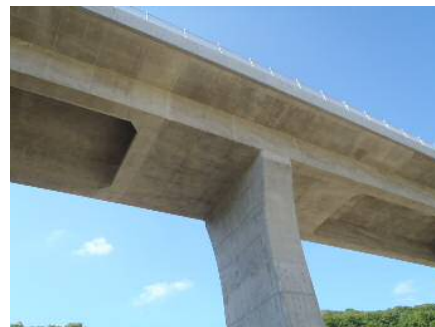
写真-6 柱頭部付近箱桁側面
