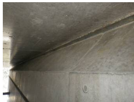
写真-8 延長床版底板先端ハンチ部
