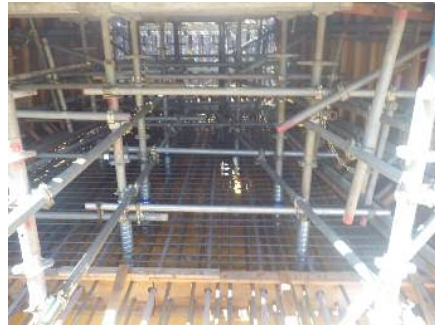
写真-3 箱桁内部支保工
