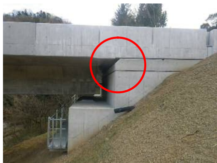
写真-7 延長床版底板先端形状
