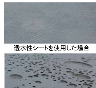
写真-2 橋面の仕上り状態
