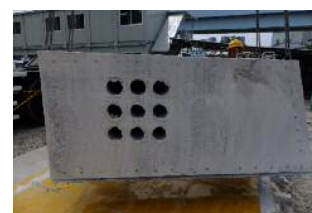
写真-3 模擬試験体の切断面における充填状況
