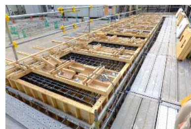
写真-1 模擬試験体の外観
