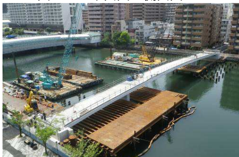
写真-1 晴海側より全景
