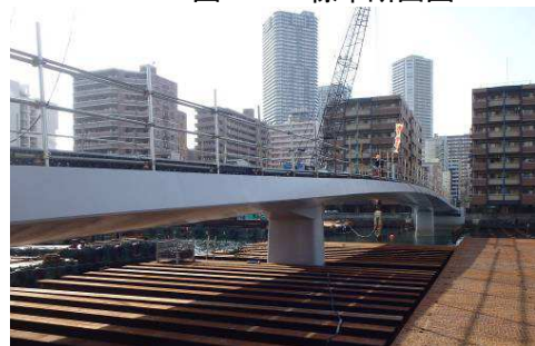
写真-2 A1側より側面全景
