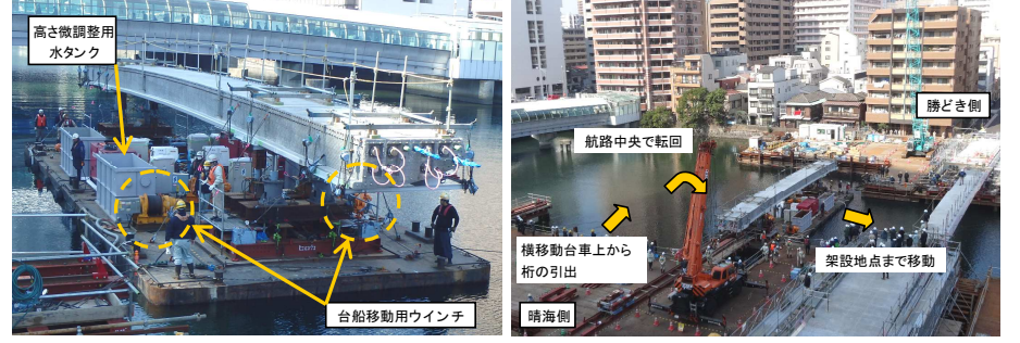
写真-6 台船艀装・移動状況写真
