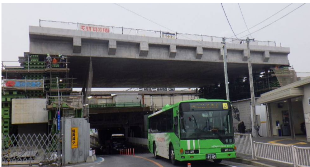
写真-1 折尾駅高架橋ジャッキダウン前の全景
