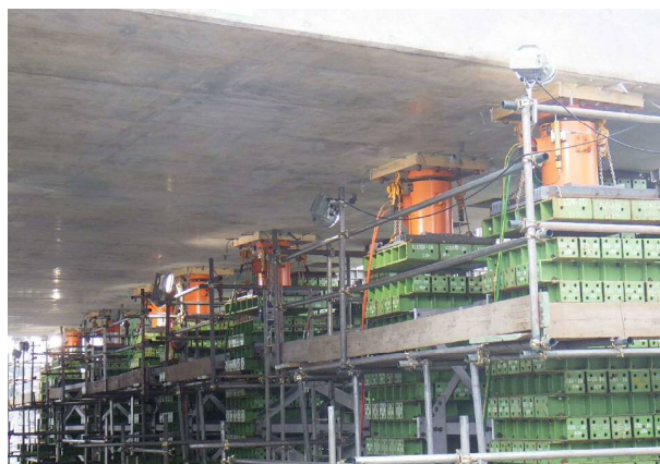
写真-2 500t ジャッキのセット状況
