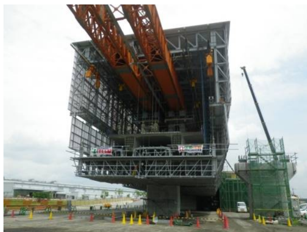
写真-1 移動支保工(上り線)全景
