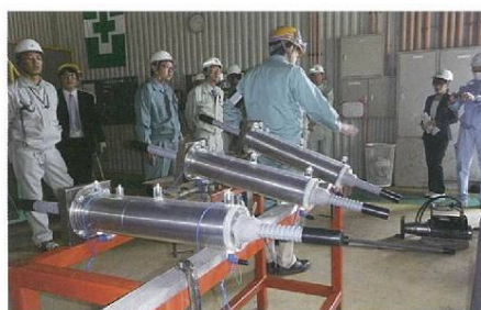
写真-3 カップラー部グラウト充填確認
